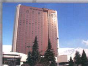
هتل بزرگ آزادی تهران - بهسازی لوزه ای ساختمان ۲۸ طبقه بتنی تقویت ستونها با FRP و استفاده از میراگرهای هیدرولیک با همکاری شرکتهای SMTeam و EMPA (سوئیس)
