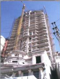
برج تندیس - تهران - نیاوران - تقویت موضعی تیرها و ستونهای بتنی با FRP به دلیل تغییر کاربری طبقات بالا
