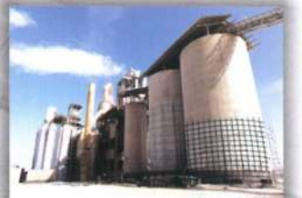
کارخانه سیمان آباد - تقویت سیلوهای بتنی و سازه های صنعتی با FRP برای افزایش عمر مفید سازه ها
