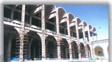
مصلی بزرگ تهران تقویت سازه های بتنی به روش Steel Jacketing
