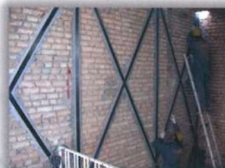
موزه دکتر شریعتی در تهران - بهسازی لوزه ای و تقویت ساختمان اجری با FRP با همکاری شرکتهای SMTeam و EMPA (سوئیس)
