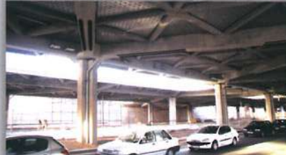
پل قم رود - قم - تقویت تیرهای بتنی با FRP Laminate
