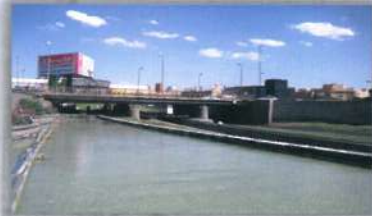
پل جانبازان تبریز - ترمیم و تقویت تیرهای بتنی با FRP به دلیل از بین رفتن میلگردها در اثر برخورد وسایل نقلیه
